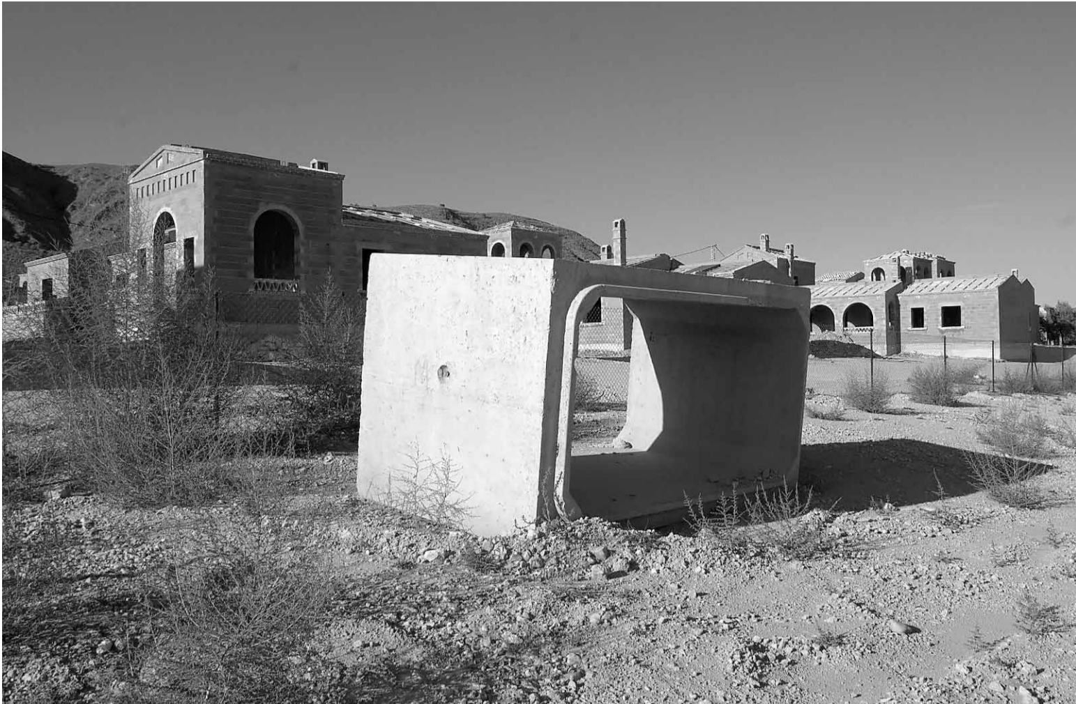
Obra abandonada. Solo unas pocas casas se terminaron; otras fases se comenzaron, y la mayoría ni se empezó a construir. :: JAD
